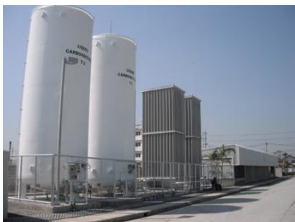
Sklop - kriogene posude s armaturom i isparivačima
