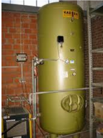
Vertikalni spremnik stlačenog zraka
